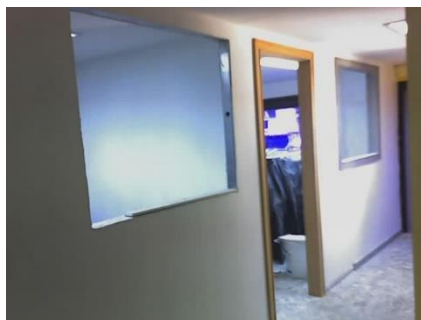
Divisórias de gesso acartonado
