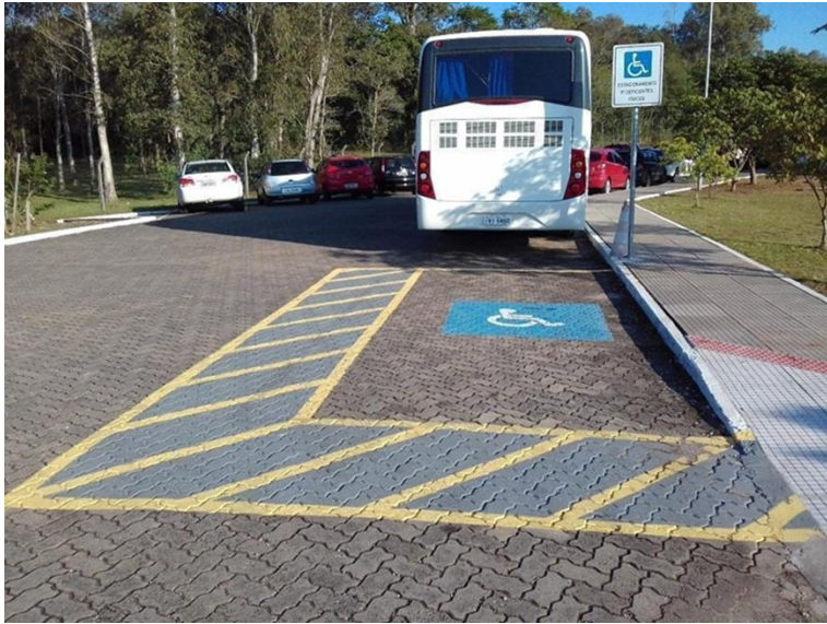
Figura 1 - Vaga de estacionamento para pessoas com deficiência física. Fonte: IFSul, Câmpus Venâncio Aires
