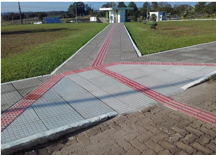
Figura 2 - Rampa para acesso a cadeirantes Fonte: IFSul, Câmpus Venâncio Aires
